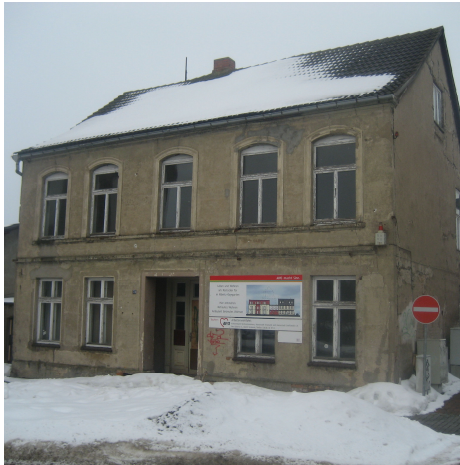
Lange Straße 73 (Rückbau 2011, derzeit Baulücke)
